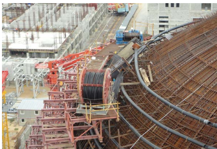
Рисунок 9 - Монтаж горизонтального армопучка до бетонирования ВЗО
